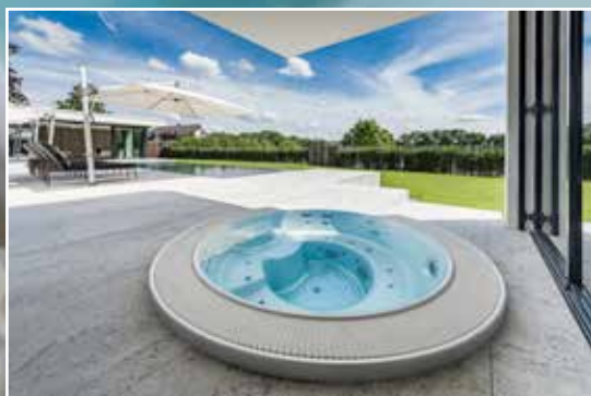
Der Whirlpool auf der Terrasse ist an die Aufbereitungstechnik des Schwimmbeckens angeschlossen.
